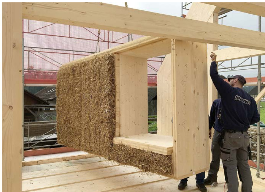
Stroh wird in gepresster Form in eine Ständerkonstruktion eingelassen und dient als Dämmmaterial.
