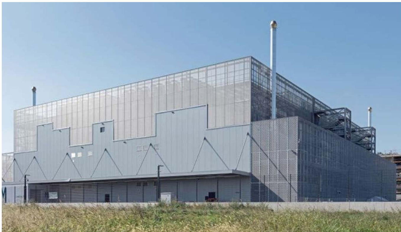
Ende 2023 ging in Dielsdorf (ZH) das erste von drei Hochleistungsrechenzentren ans Netz.
