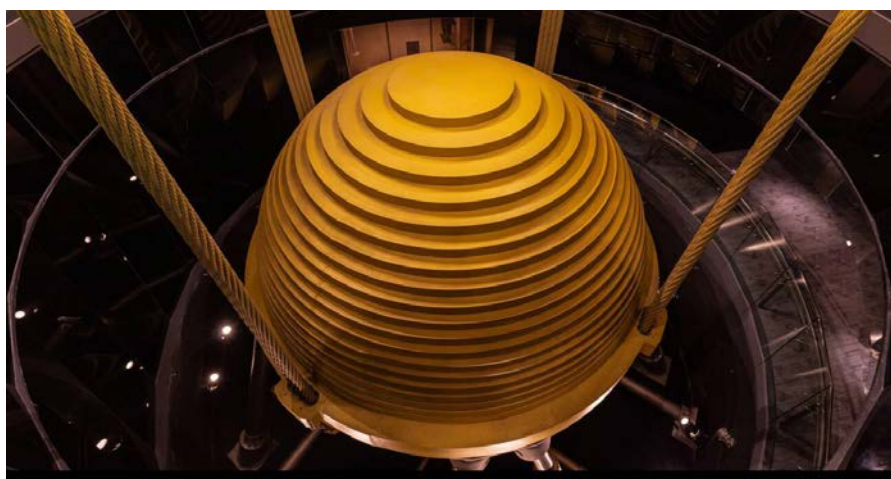
Weiterbildungsthema erdbebensicheres Bauen (s. ETH): Ein spektakuläres Beispiel dafür ist das weltweit grösste und schwerste Tilgerpendel im Wolkenkratzer Taipei 101 in Taipeh (Taiwan).
