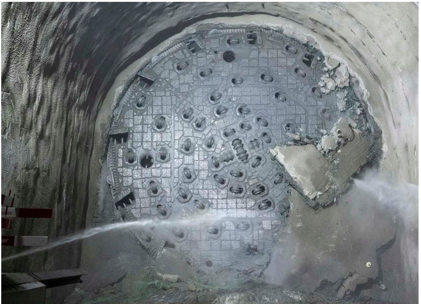
Tunnelbohrmaschine «Alessandra» beim Durchstich der nördlichen Störzone der zweiten Gotthard-Strassentunnel-Röhre (29. April 2026).
